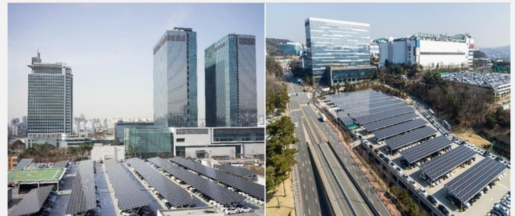
Panneaux Solaire sur les parkings des campus Samsung à Suwon et Giheung, Corée
